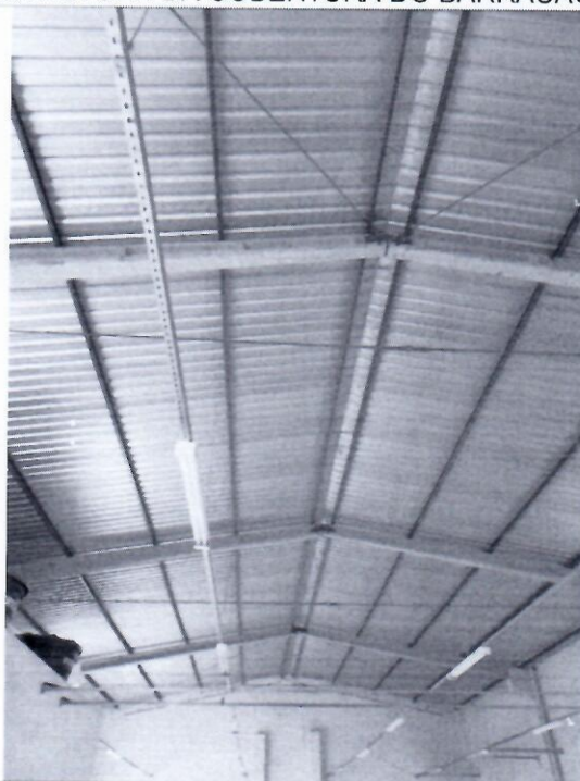
FOTO 02 – ESTRUTURA DA COBERTURA DO BARRACÃO INDUSTRIAL
