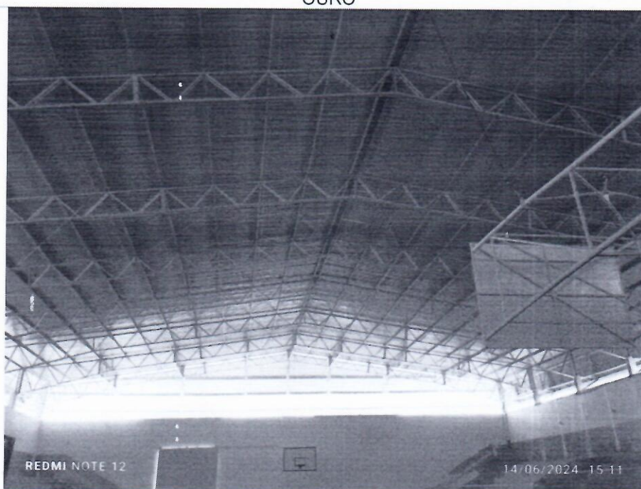
FOTO 12 – ESTRUTURA DA COBERTURA DO GINÁSIO DE ESPORTES JOSÉ RIBEIRO DO OURO
